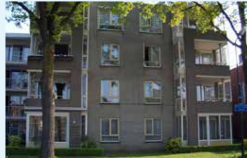
Deken Baekershof 16 appartementen nabij het centrum
