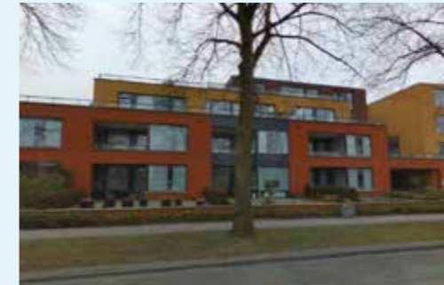
Deken Baekershof 55 appartementen nabij het centrum
