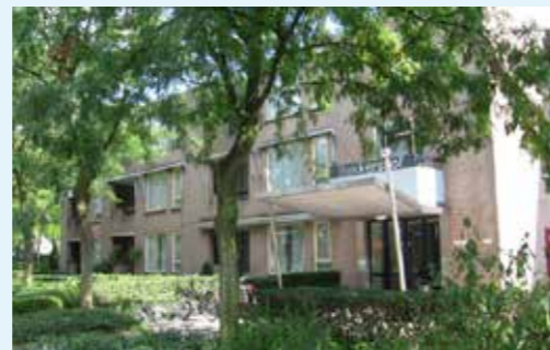
Mgr. Bekkerstraat 17 appartementen nabij het centrum
