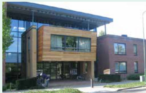
Klokakker 27 appartementen nabij centrum
