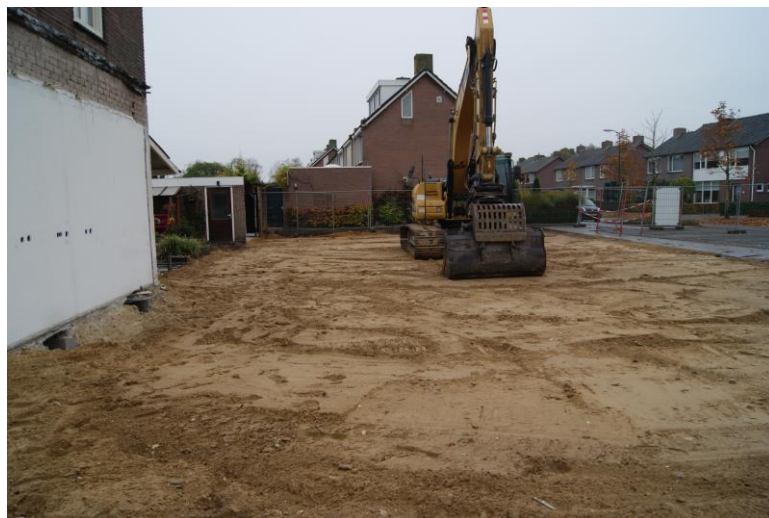
Locatie Azaleastraat wordt bouwrijp gemaakt
