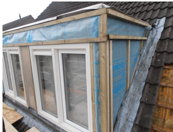
Vernieuwing afwerking dakkapel, Den Dries
